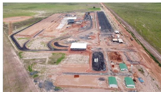
Obra em andamento
