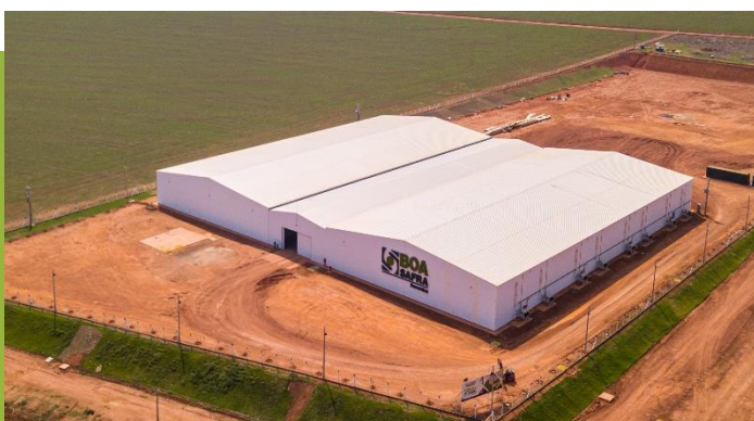
Conclusão das obras
