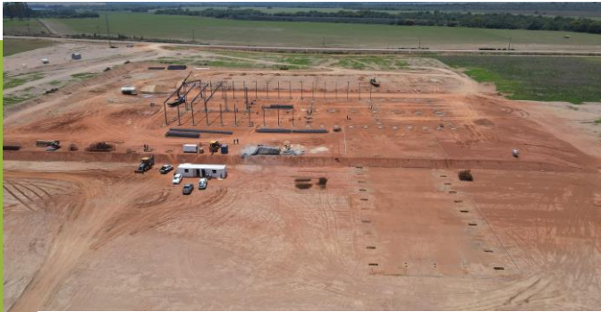
Obras em Andamento
