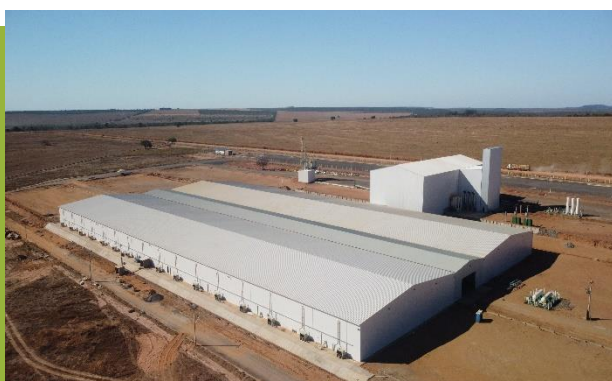
Finalização das obras
