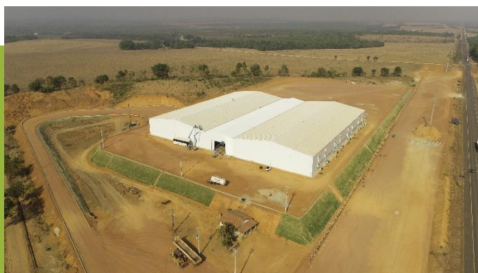
Conclusão das obras
