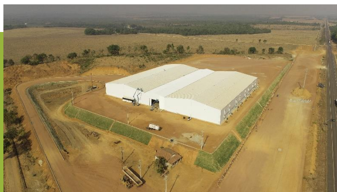
Conclusão das obras
