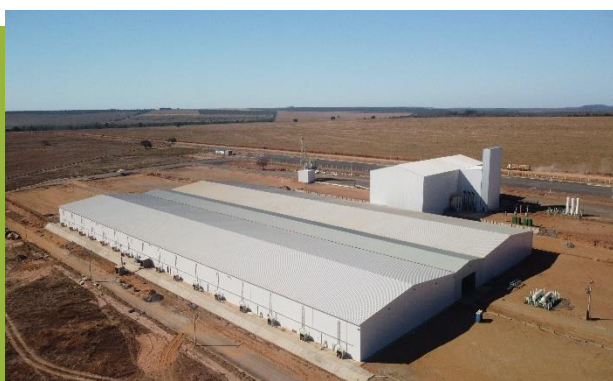
Finalização das obras
