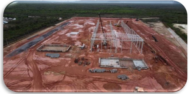
Construção Caucaia-CE (Dez/22)
