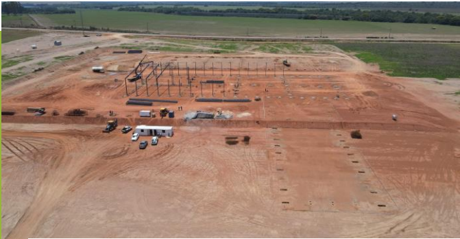
Obras em Andamento
