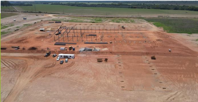
Obras em Andamento
