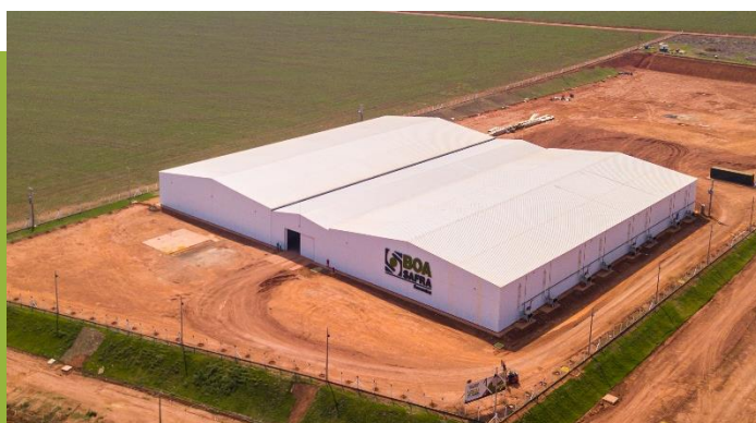
Conclusão das obras
