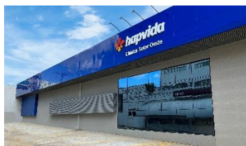
Nova Clínica Setor Oeste (GO)
