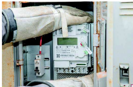
Foto: instalação de medidor
