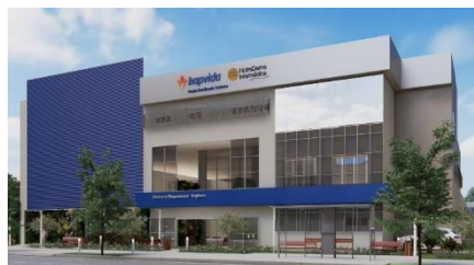
Novo Pronto Socorro Autônomo do Contorno/MG – abr'23
