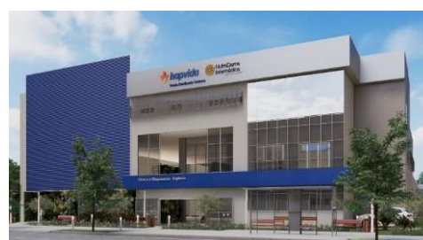
Novo Pronto Socorro Autônomo do Contorno/MG – abr'23
