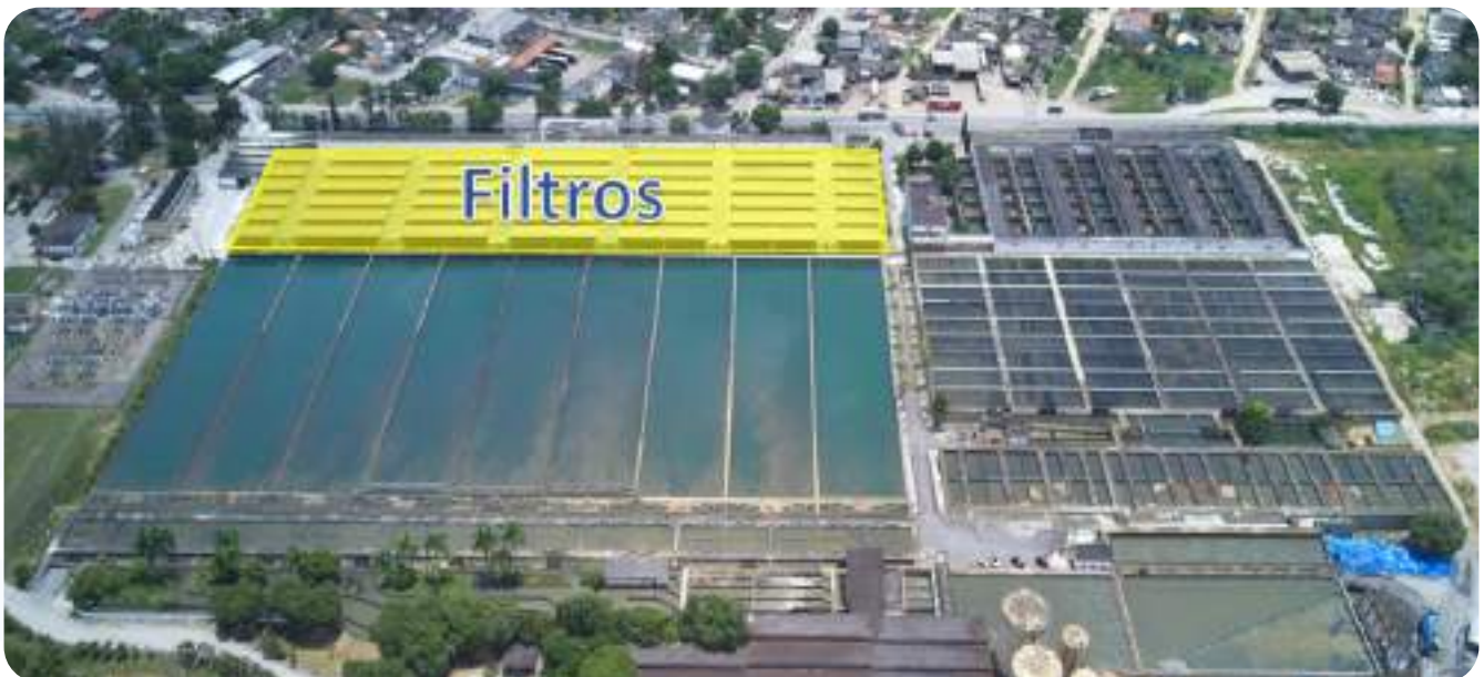
Figura: filtros na Estação de Tratamento de Água do Guandu – VETA
