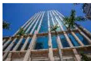
F.L. FINANCIAL CENTER ✓ Edifício Triple A São Paulo / 2003 26.513 m 2 (0% SYN)
