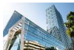
JK TORRE E ✓ Edifício Triple A São Paulo / 2013 19.418 m 2 (10% SYN)
