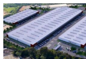
CLD (em construção) Galpão São Paulo / 2023 128.516 m 2 total (17,03% SYN) 74.139 m 2 entregue
