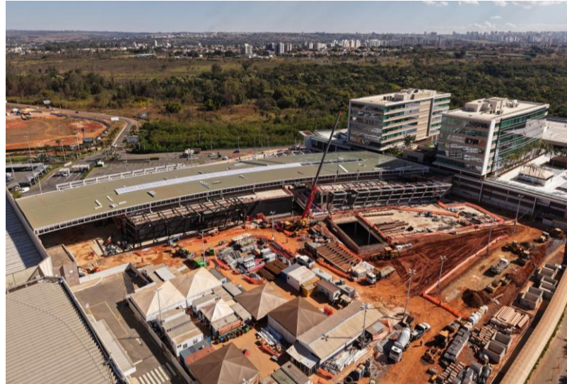
ParkShopping – Expansão em construção
